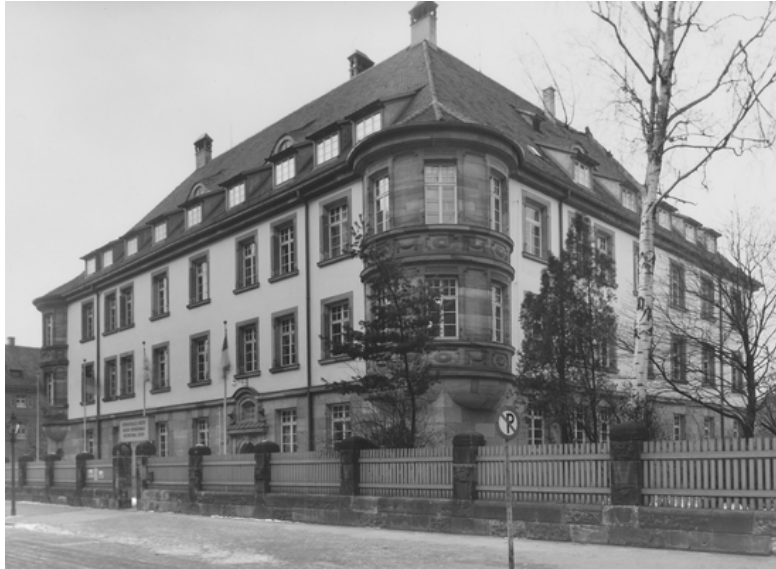
Gesamtansicht des Institutsgebäudes in der Muggenhofer Straße
