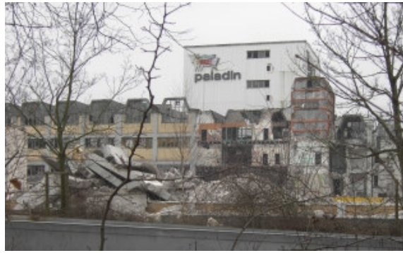
Abrissarbeiten am Hauptgebäude, Januar 2008 (Foto: Susanne Rieger)
