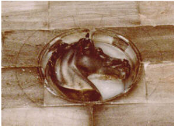
eines der Reliefs an der Fassade der Reithalle, 2003 (Foto: Susanne Rieger)
