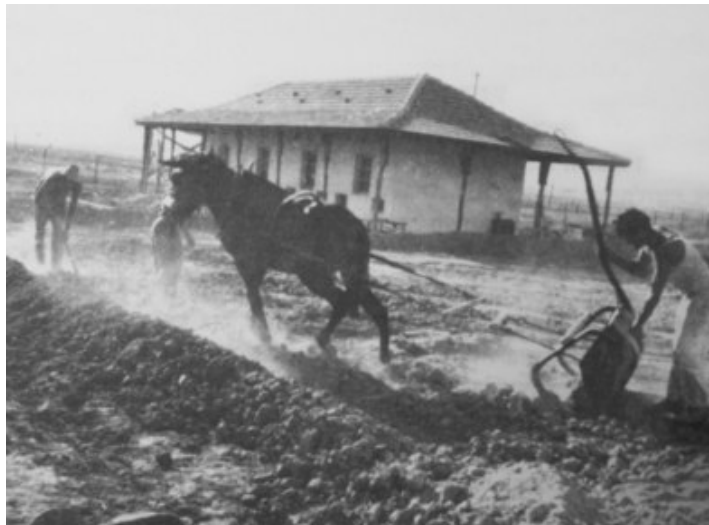
Ein Maultier zieht die Schaufel, um die Erde zu nivellieren. Das breite Dach des Hauses im Hintergrund spendet in der Wüste Schatten
