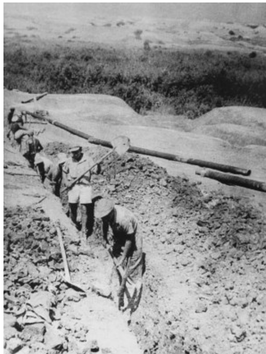
Viele Hände schaffen einen Graben für die Rohre, um das Wasser vom Jordan in die Entsalzungsbecken zu bringen
