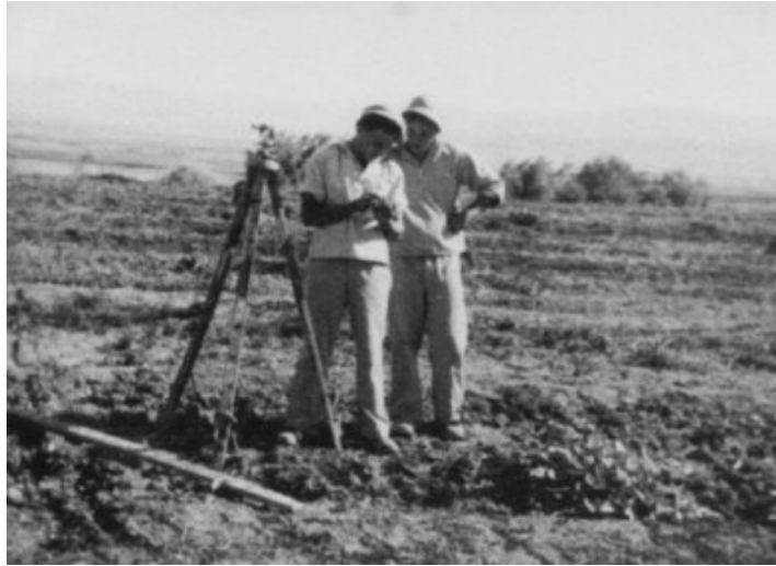
Bilder aus Beth-HaArava: Landvermessung als Vorarbeit zum Einebnen des Bodens
