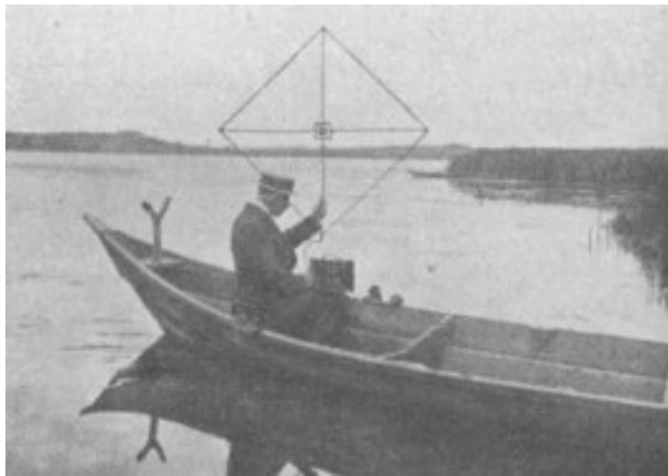
Aufnahme einer drahtlosen Nachricht mit Hilfe der aufgespannten Antenne und des Telephons in einem Boot
